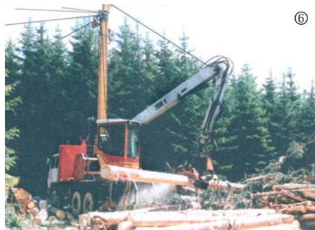
Мобилна мачтова въжена линия К-500, съоръжена с процесор и работна кабина
